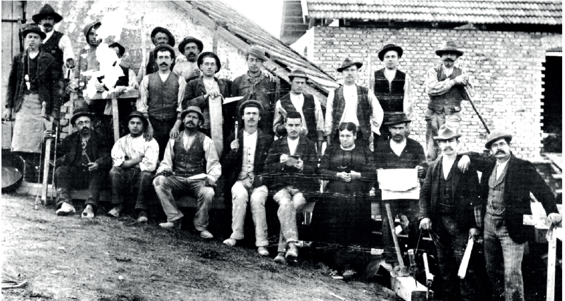
Giuseppe Ursella, secondo da destra, in Baviera nel 1898 per la costruzione di una fornace.
